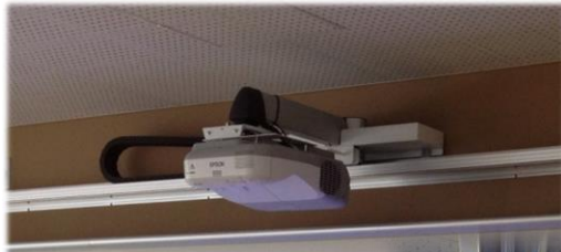
壁面スライドレール設置 AOI-SPCMWS
